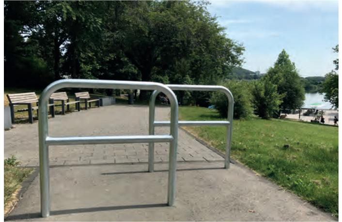
Rohrbügel aus Stahlrohr Ø 60 x 2,5 mm
